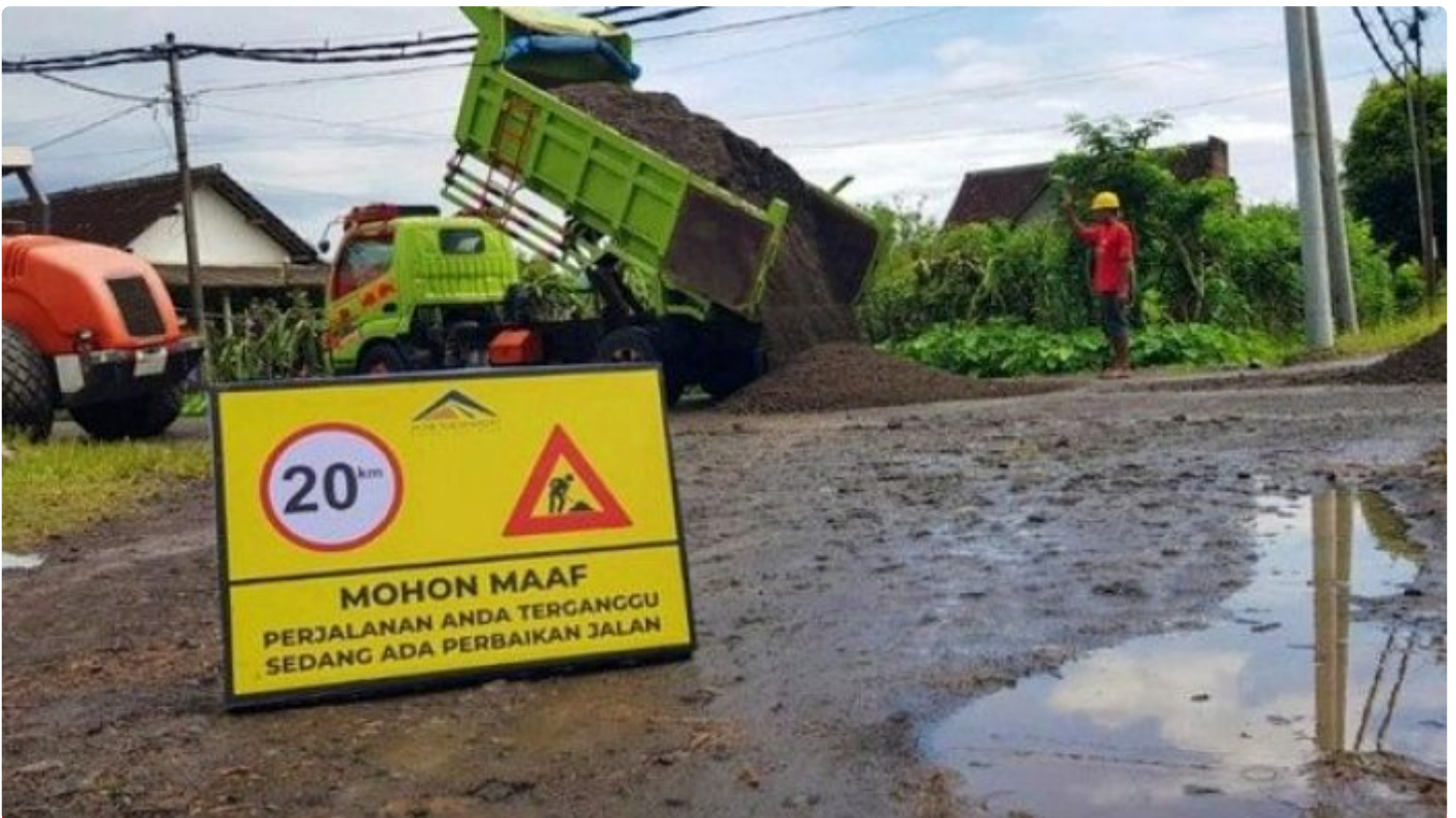
Perbaiki jalan rusak di Banyuwangi
